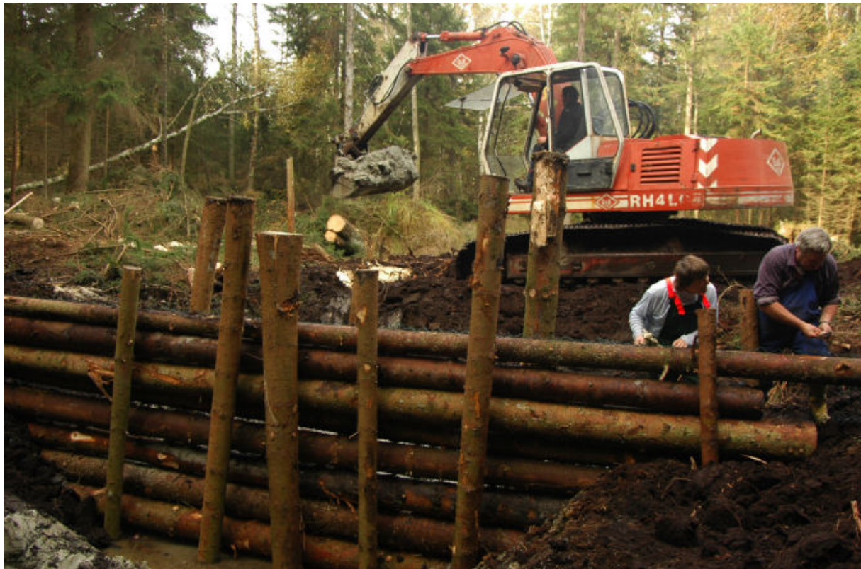
Baggararbeiten beim Dammbau
